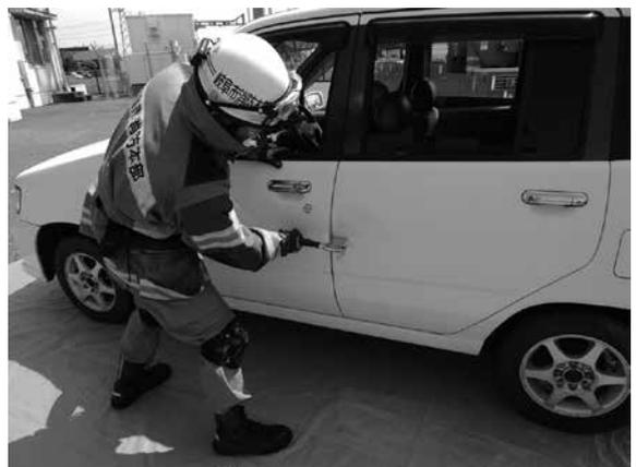
写真9 運転席ドアラッチ部分にスプレッダー先端を差し込む「隙間」の作成
