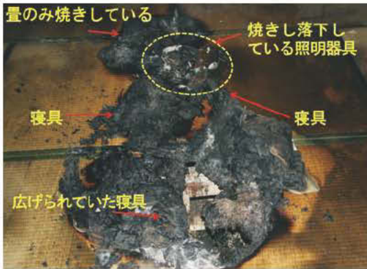
写真4 六畳間の焼き状況
