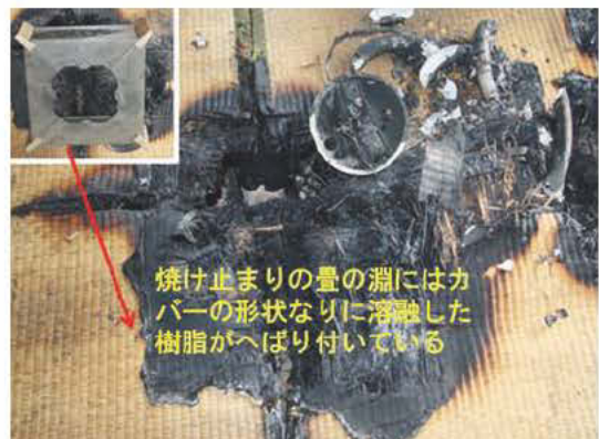
写真7 金属製の上蓋に接し燃え抜けている畳・床部分
