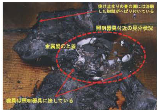
写真5 照明器具付近の焼き状況
