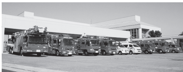
埼玉東部消防組合消防局・久喜消防署
