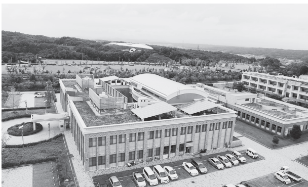
兵庫県消防学校
