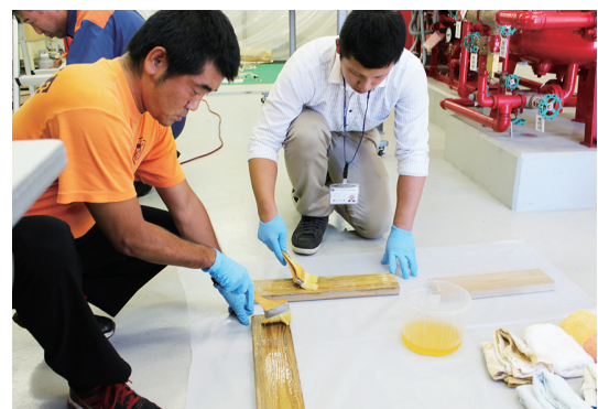
写真8 塗料の塗り込み作業
