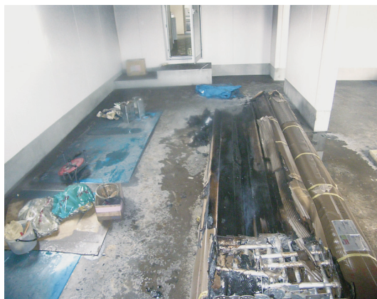
写真1 1階車庫内中央に積まれたウッドデッキ用の建築資材の状況
