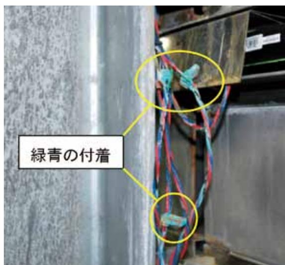
写真11 LED照明の電源配線及びコネクター
