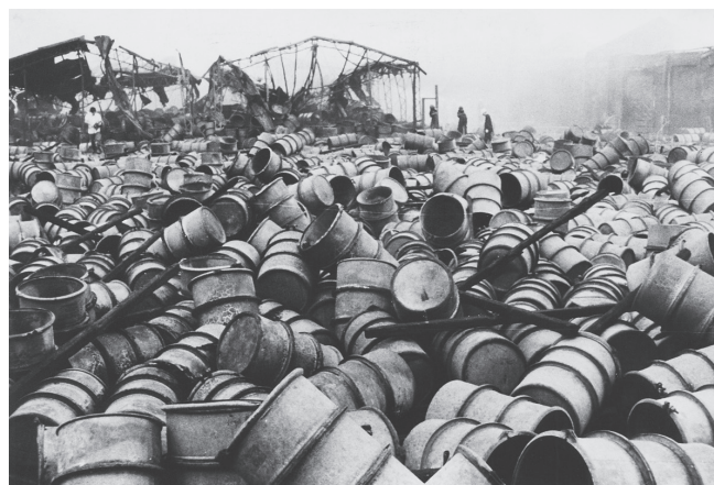
消火後の現場<写真提供/東京消防庁消防博物館>
