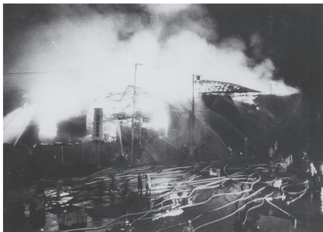
勝島倉庫爆発火災現場<写真提供/東京消防庁消防博物館>
