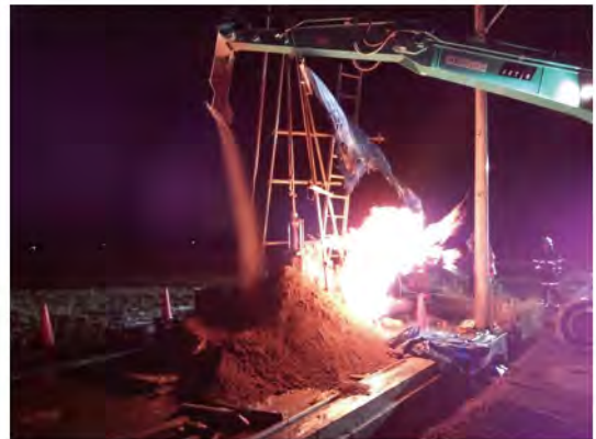
写真4 覆土消火の状況
