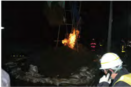
写真6 土のう設置状況
