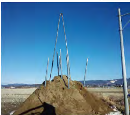
写真8 ガス抜きパイプ設置状況
