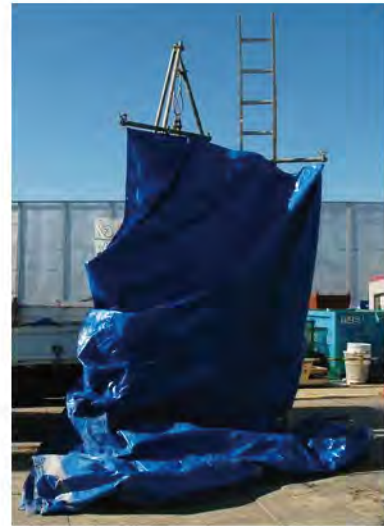
写真9 ブルーシートの設置状況
