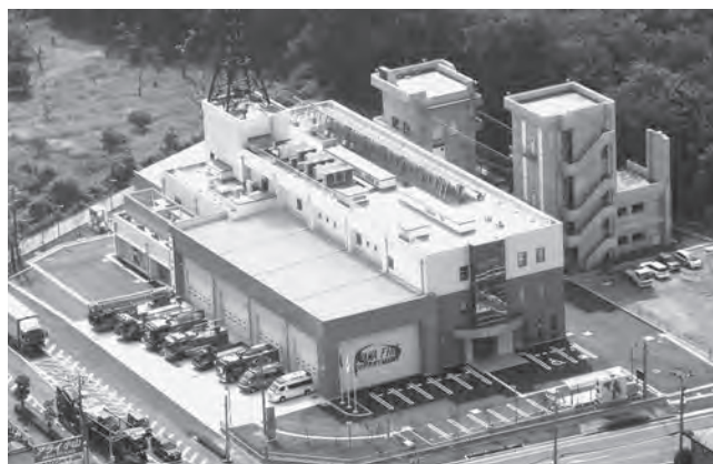
平成25年9月17日に業務を開始した小山市消防本部の新庁舎と訓練塔 鉄骨造り3階建て 敷地面積6,066.95㎡
