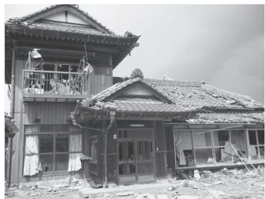
写真3 ガラスが割れている
