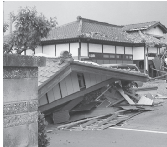
写真2 車庫が潰れている
