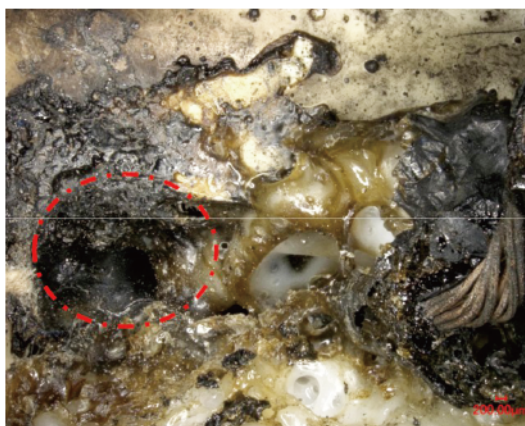
写真4 燃え抜け箇所を拡大
