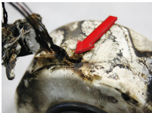
写真3 小さな燃え抜け箇所
