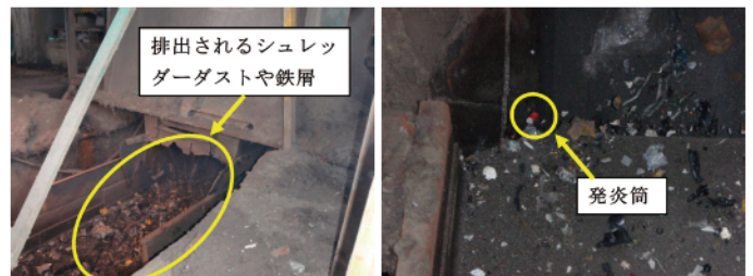
写真6 破碎機の排出口
