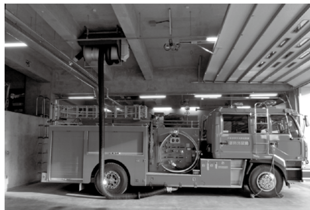
写真1 黒いホースの正体。排気ガス排煙装置
