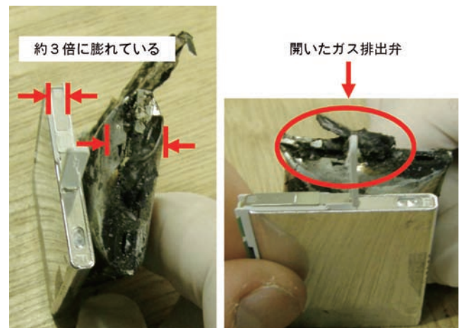
写真3 焼損した電池パックと正常な電池パックの比較
