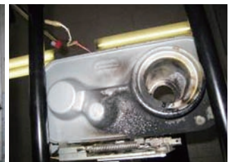
写真18 吸気口下部の状況
