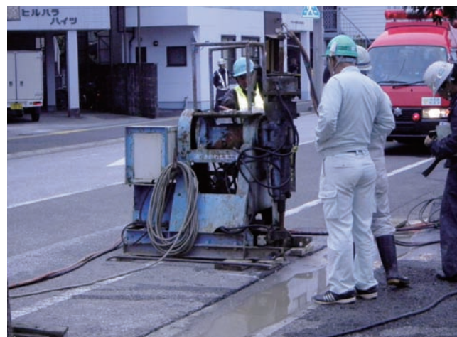
ボーリングにて土壌凝固剤を注入
