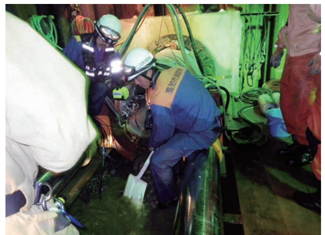
発進坑口から流れ出る地下水を処理する隊員
