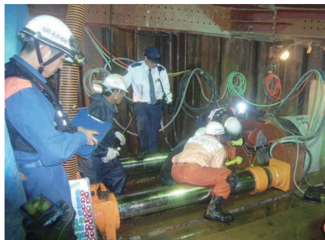
発進坑口から下水道管に進入する隊員
